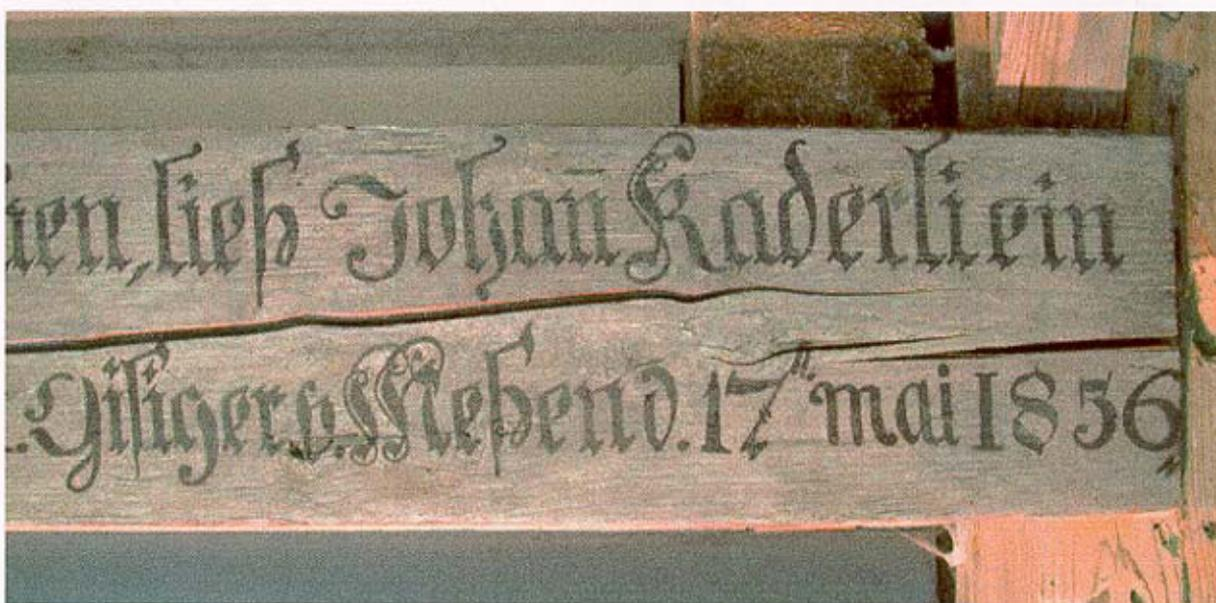
oben: Zustand nach der Reinigung, Festigung und Füllung der Bockausfluglöcher
